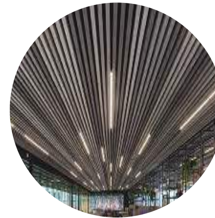
Integrazione corpi illuminanti - controsoffitto
