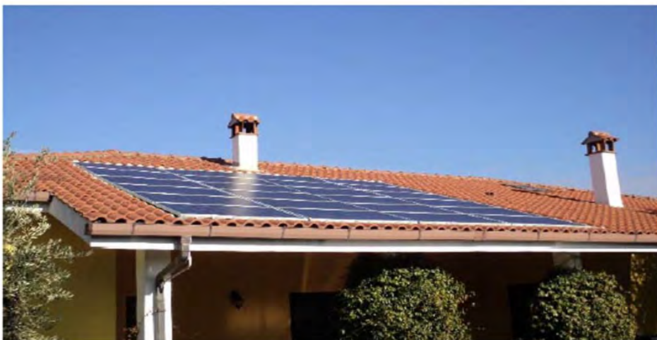
Impianto integrato da 5,5kW realizzato da Eco Logica
