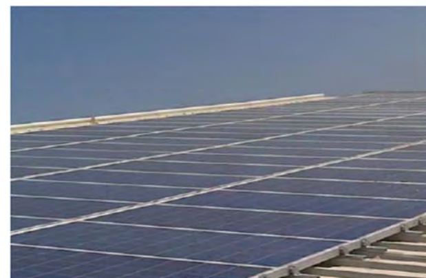
Sostituzione copertura in Amianto su capannone
