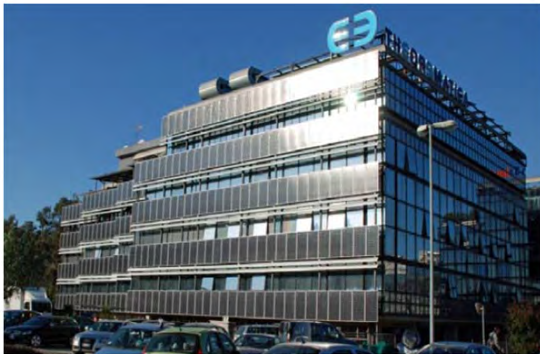
Impianto da 100kW a parete e pensilina, realizzato per Theorematica SpA, visibile dal GRA di Roma altezza Aurelia (SS1)
